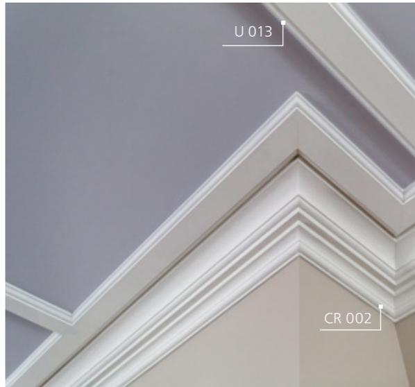
Потолок гостиной украсили ассиметричным рельефным карнизом CR 002 и декоративными кессонами, созданными с помощью широких молдингов U 013. Для создания объема использовали контрастную покраску элементов потолка. Дополнил отделку интерьера классический плинтус — Base 5271.
