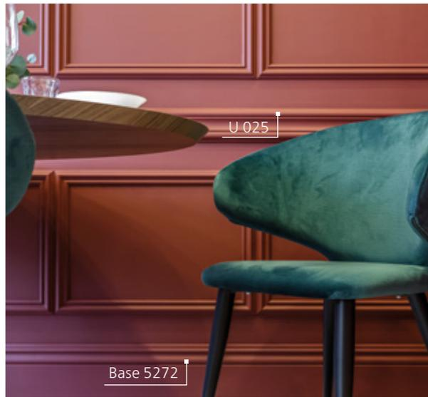
С помощью молдингов U 025 и U 002 на стенах очертили контуры, имитирующие рамы классических стеновых панелей. Это добавило отделке выразительности, создав ритмичный рельеф. Плинтус Base 5272, выкрашенный в цвет стен, сделал отделку завершенной. Потолок обрамили классическим карнизом CR 2390.
