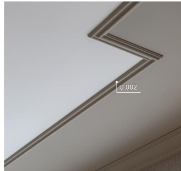
На стыке стен и потолка использовали классический карниз CR 020. Чтобы подчеркнуть высоту потолка, пространство между молдингом U 002 и карнизом покрасили в тон стен, а центр потолка – в белый. Напольный плинтус Base 003 прошел по всему периметру и завершил отделку.
